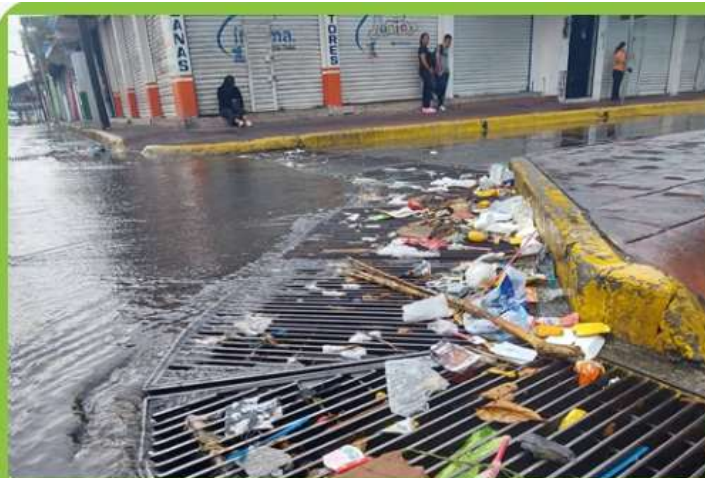
Evitar a toda costa acumulaciones de agua y basura Foto: Diario del Sur
